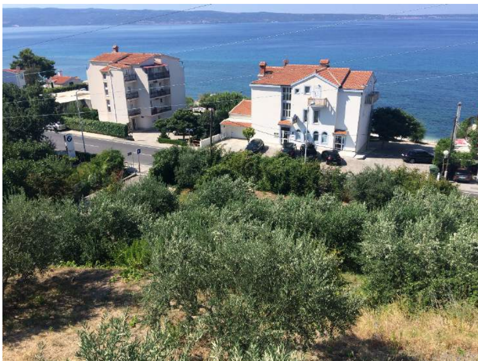
Slika 1.1.-3.: Pogled na lokaciju zahvata sa sjevera
